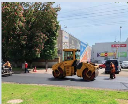
За сприяння депутатів-азотівців в різних мікрорайонах міста ремонтуються дороги
